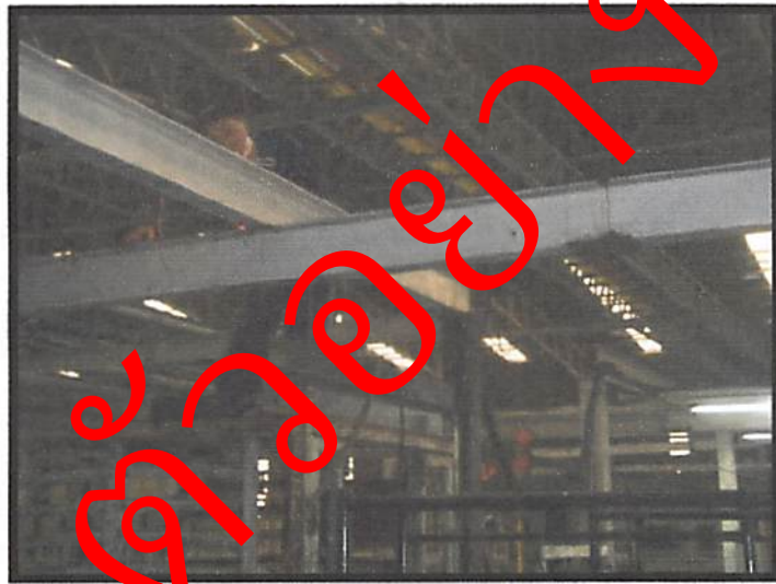
รูปที่ 5 แสดงคานไอบีมเป็นตัวยึด Hoist
